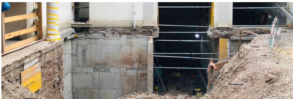
Ouvrage après exécution des sous-ouvrages
