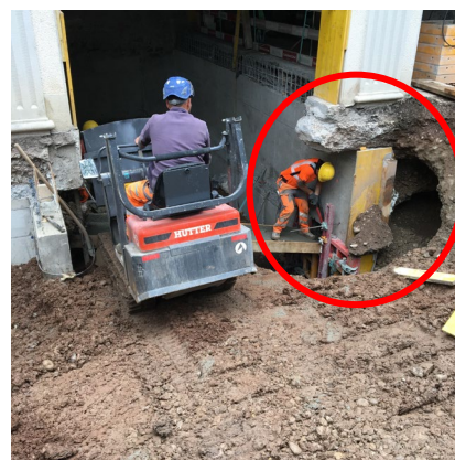
Exemple de vide dans le terrain
